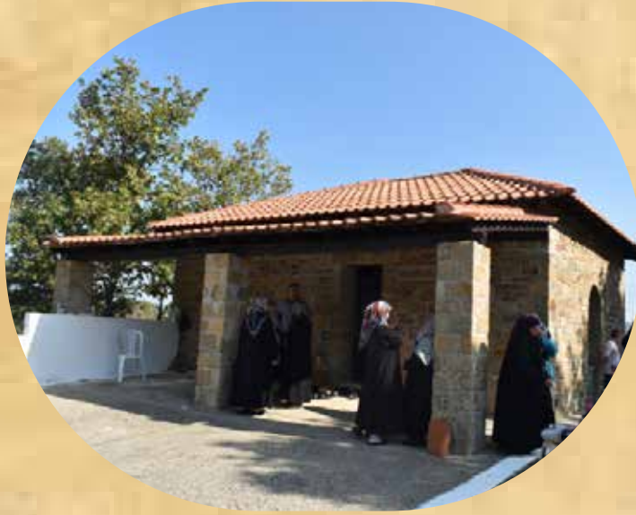
Gelin Mezarı binası
